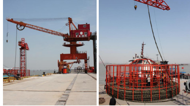
将电缆下放到驳船上，运往位于亨通（常熟）高压海底电缆工业园港口码头的海上安装现场。（由亨通集团提供）
